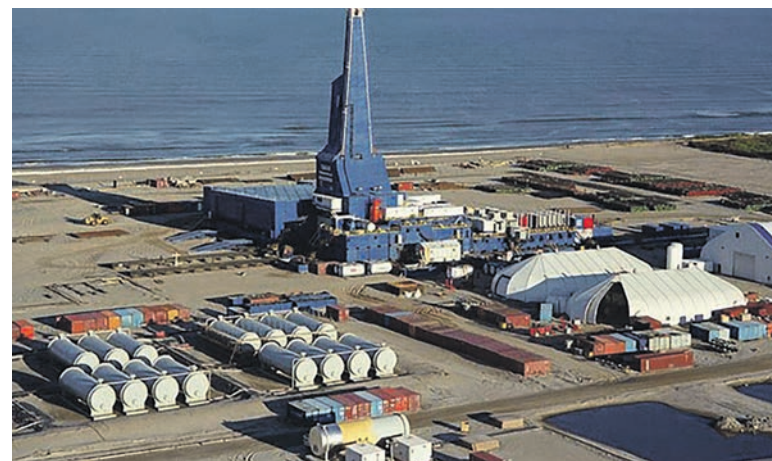
Plateforme d'exploitation du gisement gazier de Chayvo à Sakhaline.
