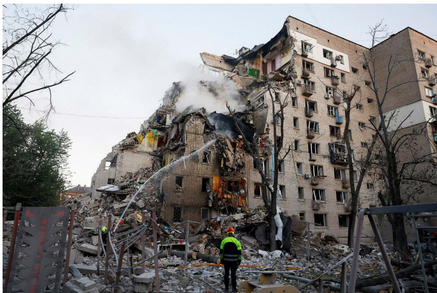
À Kiev, un immeuble d'habitation après un raid russe, le 2 juin.
