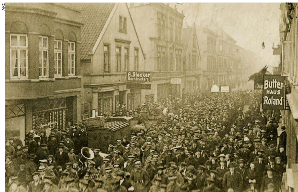
Le 6 novembre 1918, Wilhelmshaven, les débuts de la révolution allemande.
